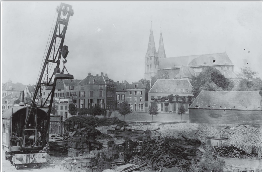
Een kijkje op de werf, voorzien van een op rails lopende magneetkraan, met aanblik op de directiewoning (klimop), Bergkerk en het prachtige Bergkwartier
