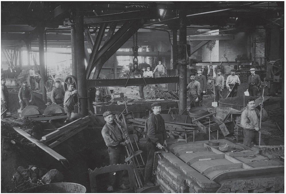
Een productieloods met vele (vak)arbeiders, veel stof, lawaai, en lange werkdagen. Er was behalve in loopkranen en enkele takels nog maar weinig geïnvesteerd in hulpmiddelen.
